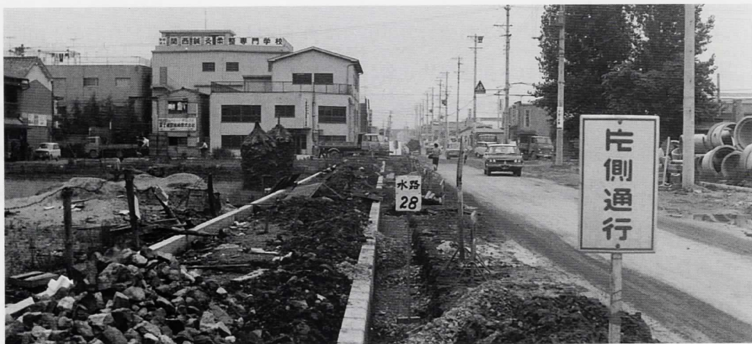
道路・水路整備工事
