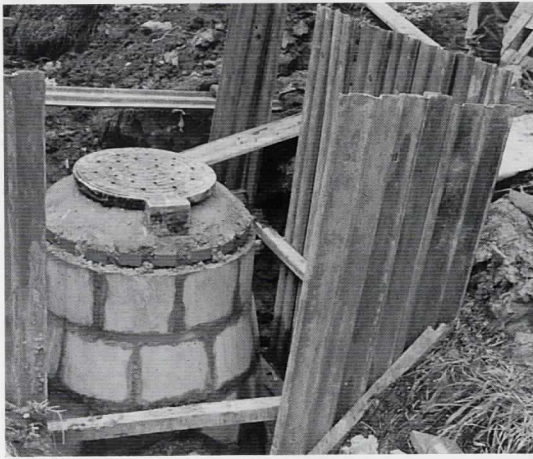
人孔築造工事
