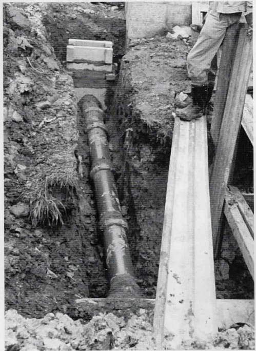
集水樹枝管取付工事
