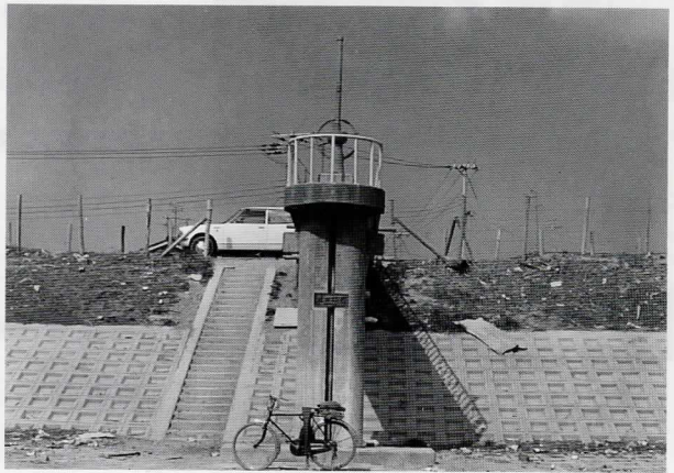
苅田排水樋門
