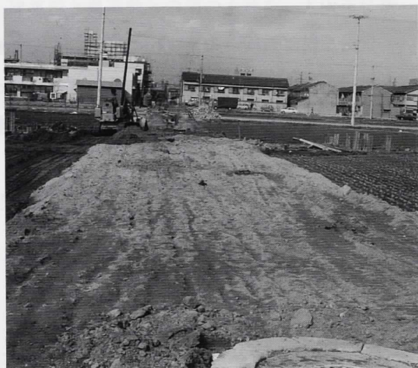
道路整備工事
