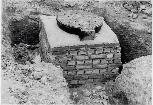
工事中の人孔
